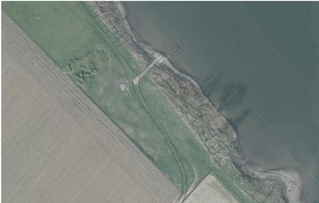
Afbeelding 7: Bestaande botenhelling, aanlegsteiger en dagstrand aan de Maas. De botenhelling is geasfalteerd.
