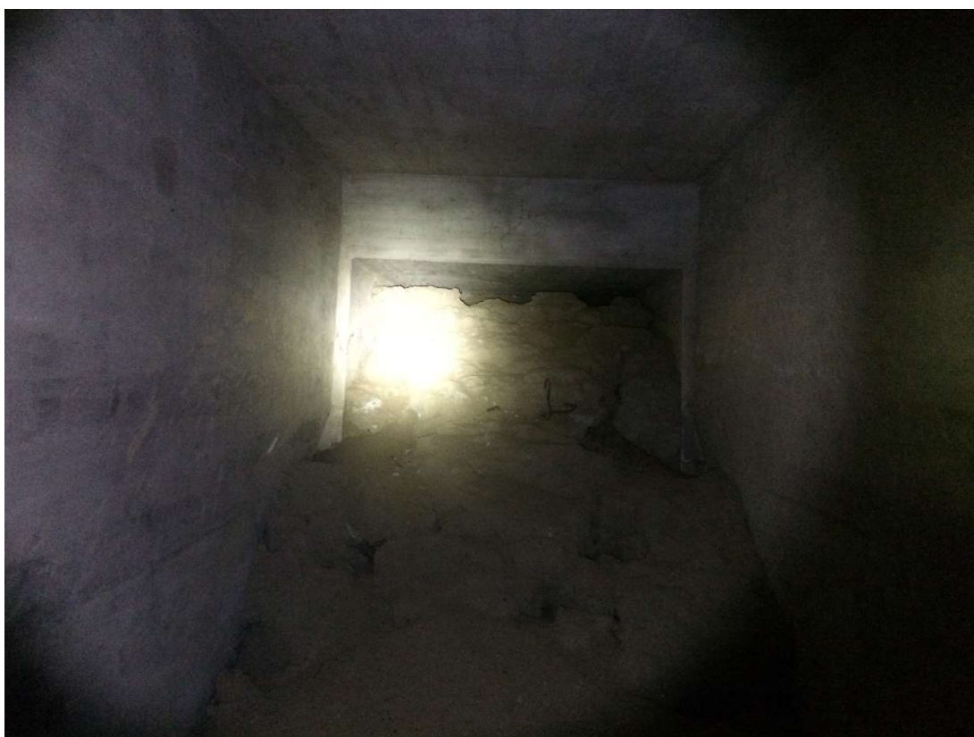
Figuur 4.1.9: Impressie van interne ruimte in de betonconstructie van het bruggenhoofd.
