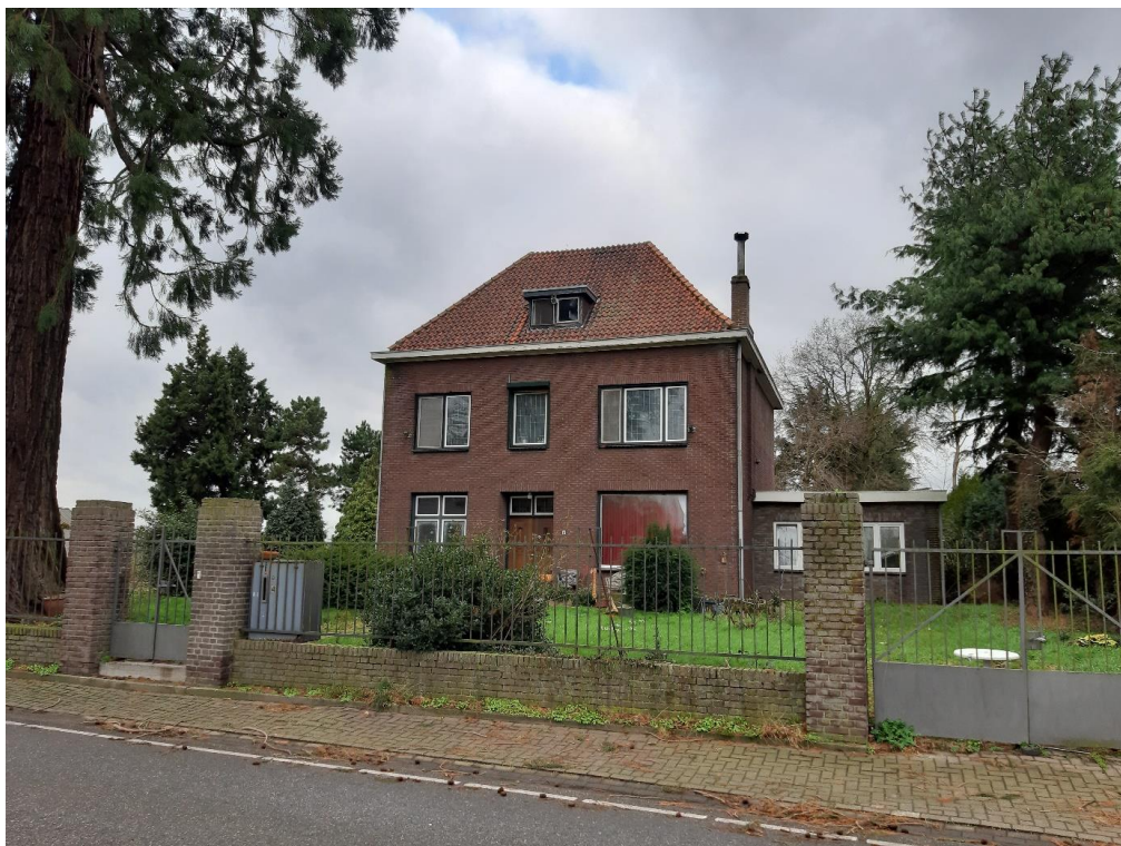
Foto 2: Te slopen woning Kasteelweg Baexem.
