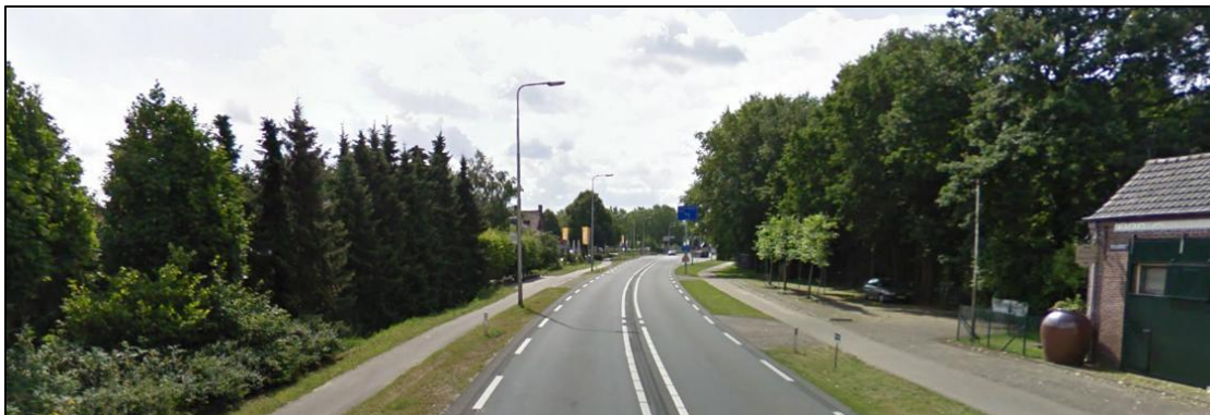
Figuur 1.2: De zuidelijke grens van het plangebied ter hoogte van de Rijksweg 2 te Nieuw Bergen
